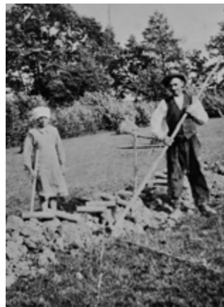
Wojciech Jekiełek z żoną w czasie prac drenażowych.
