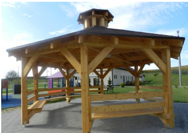
Altana przy Ośrodku Sportu i Rekreacji w Osieku
