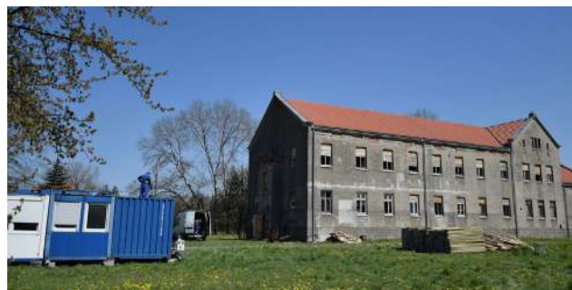
▲ Rozpoczęła się przebudowa budynku przy ul. św. Maksymiliana Kolbego w Oświęcimiu, w którym znajdzie się siedziba Muzeum Pamięci Mieszkańców Ziemi Oświęcimskiej
