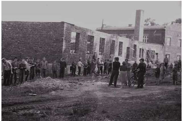
Budowa Wiejskiego Domu Kultury
