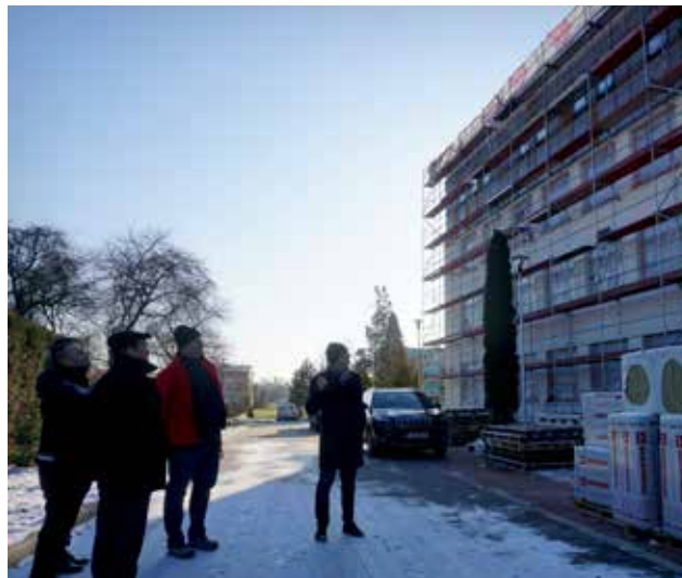
Na zdjęciu: Największym wyzwaniem pozostaje dokończenie rozbudowy Specjalnego Ośrodka Szkolno-Wychowawczego w Oświęcimiu.
