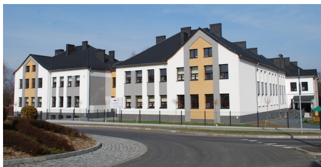
Kompleksowa modernizacja budynku ZSP Nr 1 w Osieku
