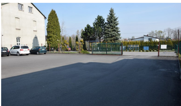
Remont parkingu przy SP Nr 2 w Osieku
