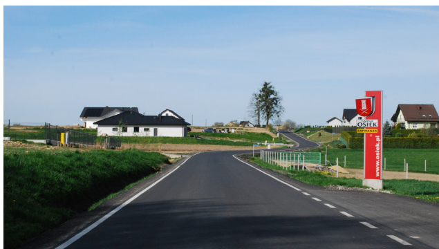
Modernizacja ul. Wadowickiej w Głębocicach
