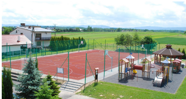
Budowa wielofunkcyjnego boiska sportowego wraz z wyposażeniem przy Szkole Podstawowej Nr 2 w Osieku
