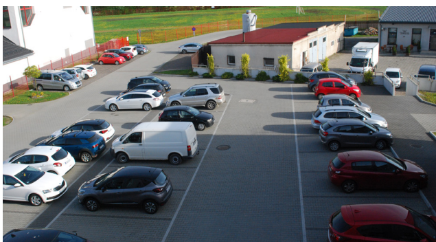
Budowa parkingu przy Urzędzie Gminy
