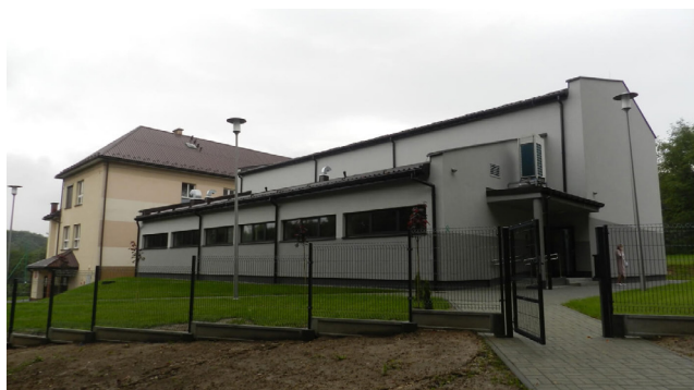
Budowa sali gimnastycznej przy ZSP w Głębowicach
