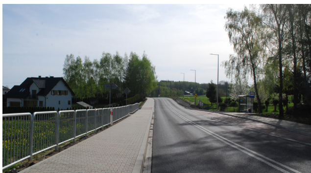
Rozbudowa DW nr 949 w Osieku
