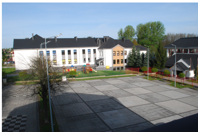
Budowa placu rekreacyjnego przy Urzędzie Gminy
