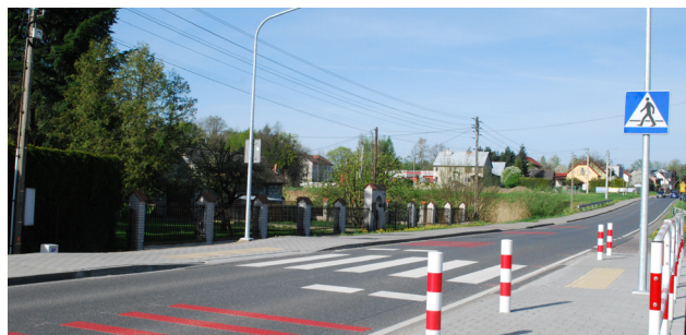
Przebudowa przejścia dla pieszych, ul. Główna w Osieku
