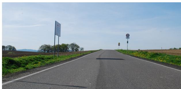
Modernizacja ul. Czereśniowej w Osieku
