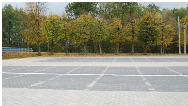
Budowa parkingu przy ul. Kościelnej w Osieku
