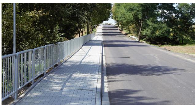
Modernizacja ul. Wadowickiej w Głębocicach
