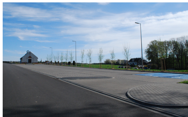
Budowa parkingu przy kaplicy cmentarnej w Osieku
