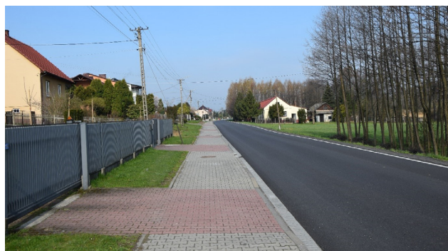
Modernizacja ul. Głównej wraz z oświetleniem w Osieku
