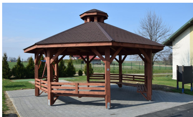
Budowa altany przy SP Nr 2 w Osieku
