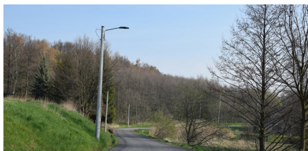
Modernizacja ul. Zabrzeżynie wraz z oświetleniem w Osieku
