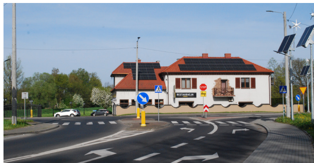
Budowa prawoskrętu na ul. Tarniówka wraz z oświetleniem w Osieku
